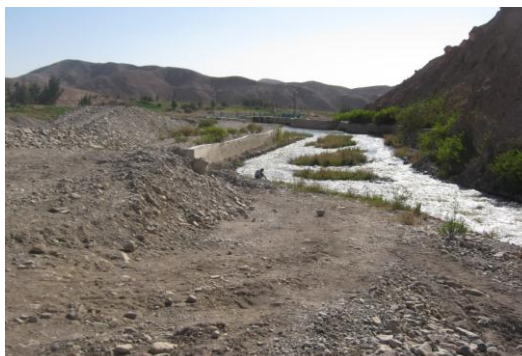
Vista fotográfica del cauce del río Uchusuma aguas arriba del barrage de la bocatoma Chuschuco
