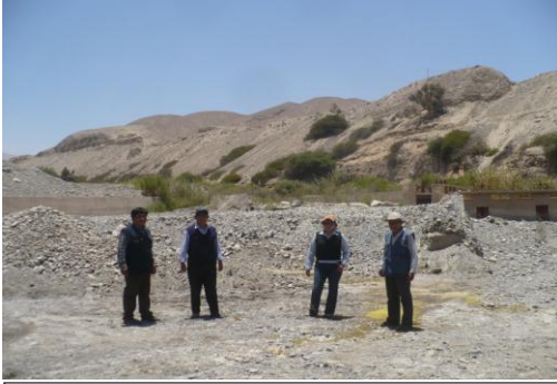
Vista fotográfica de la Bocatoma Calientes, colmatada en un 85%
