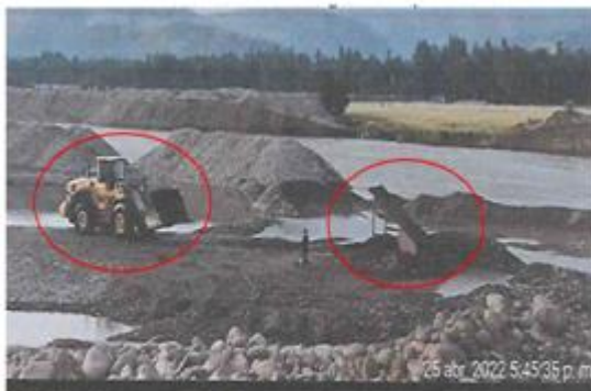
Fotografía 01: Maquinaria pesada dentro del cauce realizando trabajos de extracción de material de acarreo. Con zaranda metálica instalada dentro del cauce.
