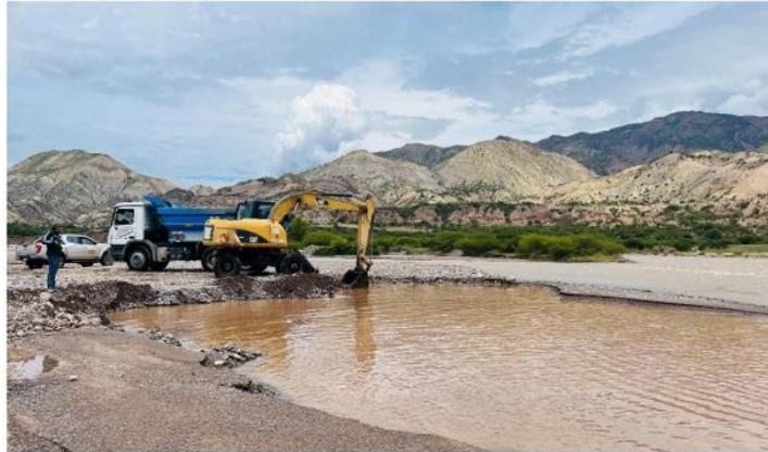
FOTO 01: AREA DE INTERVENCION EN LA QUE SE APRECIA LAS MAQUINARIAS EN PROCESO DE EXTRACION DEMATERIAL DE ACARREO, PRODUCTO DE ELLO EL DAÑO AL CAUCE CON UNA EXCAVACION PROFUNDA.
