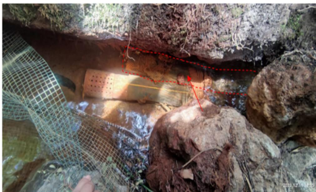
Fotografía N° 02: Tubería hdpe de 3" que ingresa al "Recreo turístico San Lorenzo", la misma que se constató e inicia en las en las coordenadas UTM WGS 84 497834E, 8622878N.
