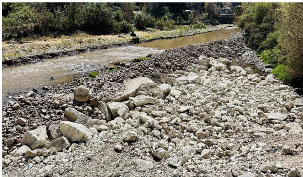
FOTO 02: AREA DE INTERVENCION EN LA QUE SE APRECIA LA OCUPACION DEL CAUCE CON LA CONFORMACIÓN INADECUADA DEL DIQUE
