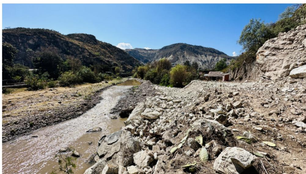
FOTO 03: AREA DE INTERVENCION EN LA QUE SE APRECIA LA OCUPACION DEL CAUCE CON LA CONFORMACIÓN INADECUADA DEL DIQUE
