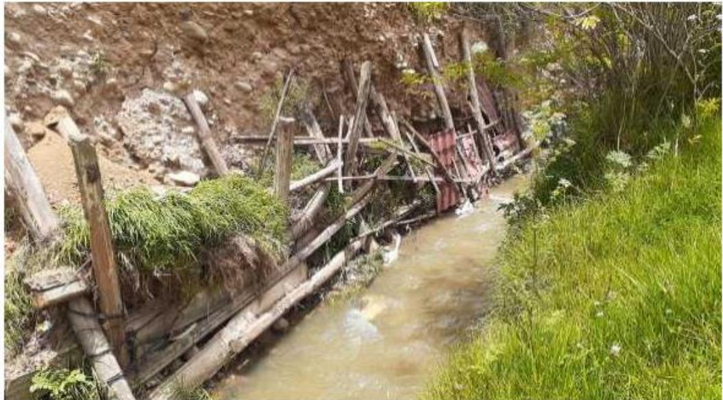
Se constató un acantilado de 5.00 metros de alto donde se viene erosionando el talud del terreno, asimismo el Sr. Juan Ávila Paitan – propietario del predio manifiesta que en el mes de noviembre a colocado los palos, realizando tipo defensa para evitar el deslizamiento del talud en esta época de avenida.
