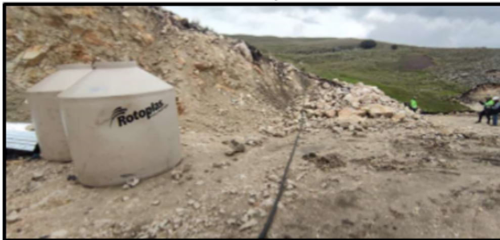
Fotografía N° 08: Se observa dos cilindros que almacenan agua y una manguera negra hdpe de 1" que alimenta los cilindros, ubicados aledaños a la construcción de las 02 pozas de sedimentación, dentro de las instalaciones de la Unidad Esperanza de la COMACSA
