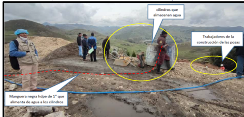
Fotografía N° 03: Se observa dos cilindros que almacenan agua y una manguera negra hdpe de 1" que alimenta los cilindros, ubicados alejados a la construcción de las 02 pozas de sedimentación, dentro de las instalaciones de la Unidad Esperanza de la COMACSA
