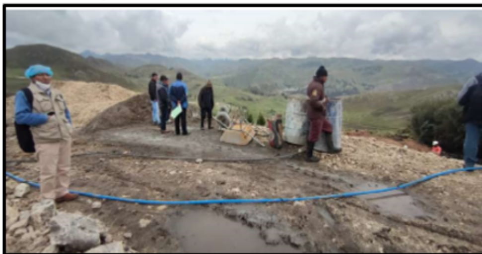
Fotografía N° 08: Se observa dos cilindros que almacenan agua y una manguera negra hdpe de 1" que alimenta los cilindros, ubicados aledaños a la construcción de las 02 pozas de sedimentación, dentro de las instalaciones de la Unidad Esperanza de la COMACSA
