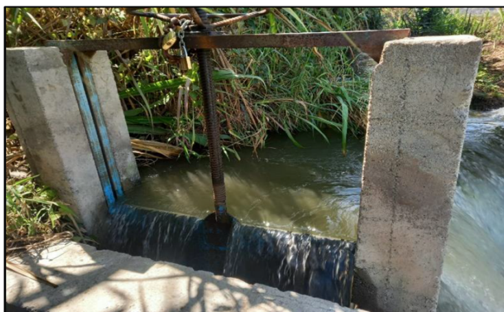
Fotografía del Informe Técnico N° 0045-2022-ANA-AAA.CHCH-ALA.P/LCDL (Fuente: JUSHMP, donde se muestra la compuerta levantada)
