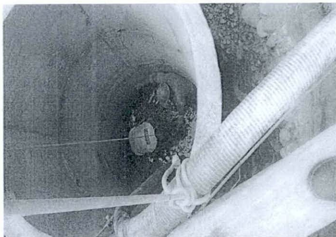
Fotografía N° 02 vista de afloramiento de agua en el pozo a Tajo Abierto Artesanal construido
