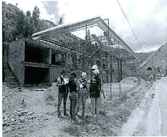
Fotografía N° 01.- Vista de la construcción conjuntamente con las autoridades como: FEMA, DREM, OEFA y Municipalidad Provincial de Ambo, en la zona urbana de San Rafael en la margen izquierda del río Huallaga.
