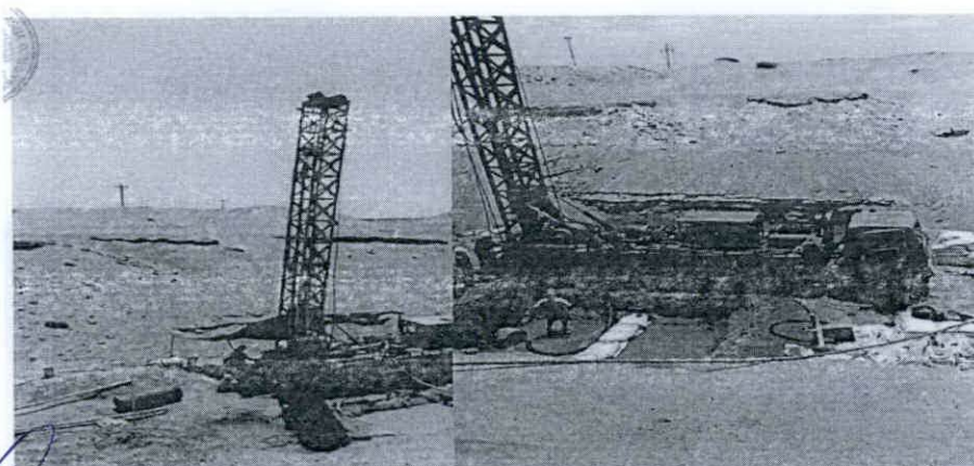
Foto N° 01 En la imagen se aprecia una máquina tipo Bucyrus en plena perforación de un pozo nuevo en el Fundo "El Arenal" de propiedad de la empresa Novoliz S.A. se visualiza claramente la rampa o excavación que ha hecho con la finalidad camuflar la actividad hidráulica de perforación de un pozo que están realizando.
