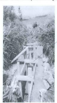
Vista de la construcción e instalación de la compuerta de regulación por parte de la Comisión de Usuarios Pasamayo en el canal F1-La Ladrona.
