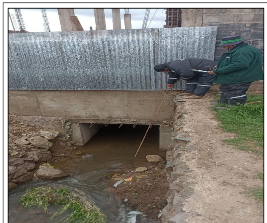
**Vista N° 04:** En la vista fotográfica se puede observar la alcantarilla construida por el propietario con las siguientes características de 1.80\*1.00 metros, con material concreto, y fierro, encima de esta alcantarilla viene construyendo una vivienda.
