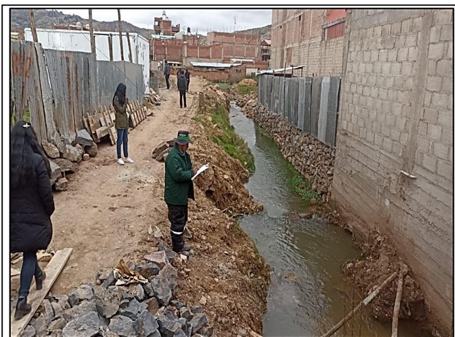
**Vista N° 03:** En la vista fotográfica se puede observar en la margen izquierda también viene ocupando el cauce y margen derecha el relleno con material de desmonte, donde se puede observar una plataforma de tierra obstruyendo el cauce y el camino de vigilancia del cauce para fines de mantenimiento.
