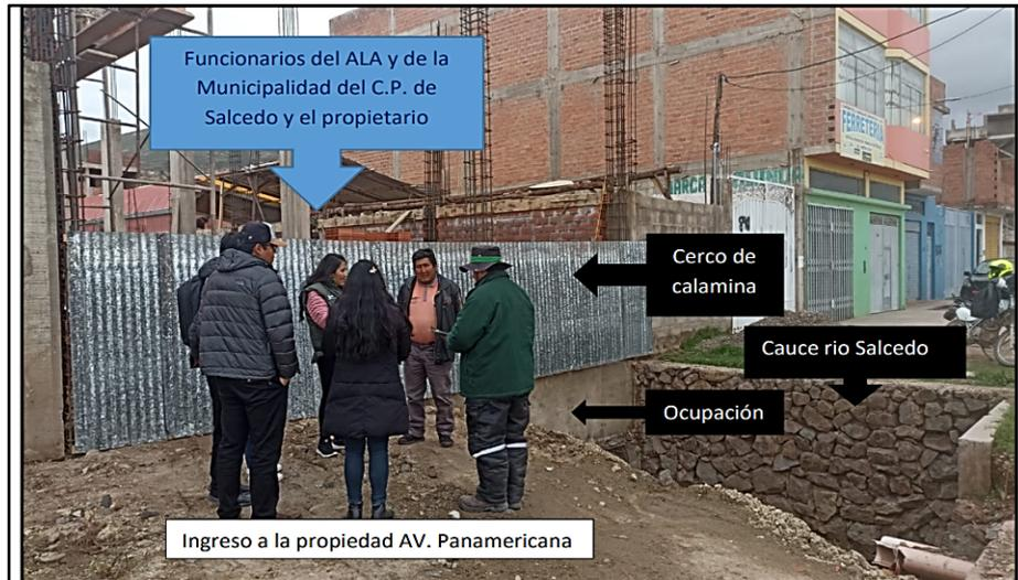
**Vista N° 01:** En la vista se aprecia la ocupación del cauce y también se observa el cerco con material de calamina sobre el cauce y que se puede observar la construcción en su interior por el propietario la construcción sobre el cauce del río y de esta manera se viene obstruyendo el cauce y el camino de vigilancia del cauce.
