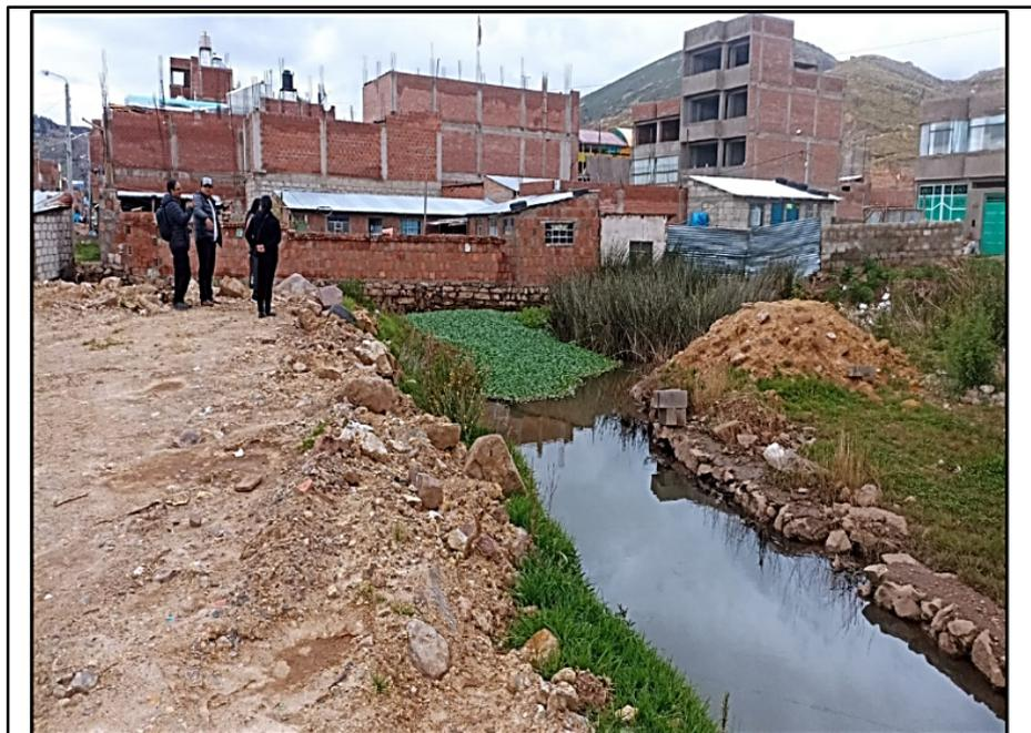
**Vista N° 02:** En esta vista se aprecia el cauce de agua del río Salcedo Aguas Arriba donde se viene ocupando y se tiene un ancho de 3.50m y también se aprecia el relleno con material de desmonte a las orillas del río y de esta manera viene obstruyendo el cauce y el camino de vigilancia del cauce.
