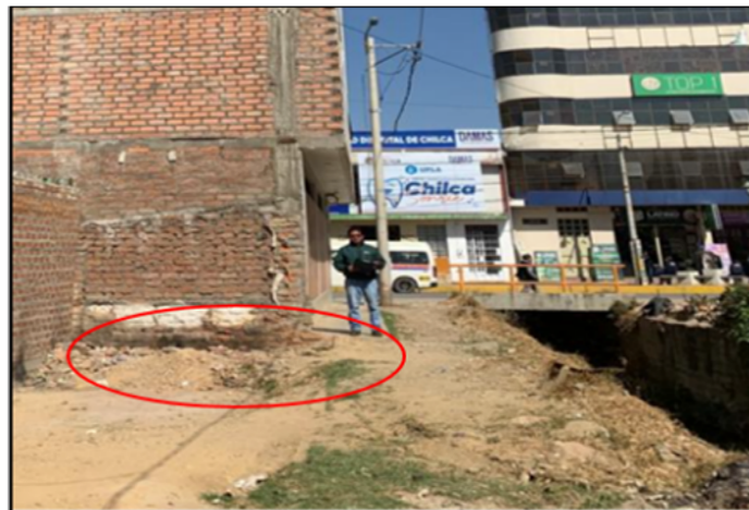
Fotografía 02: se aprecia el predio invadiendo faja marginal
