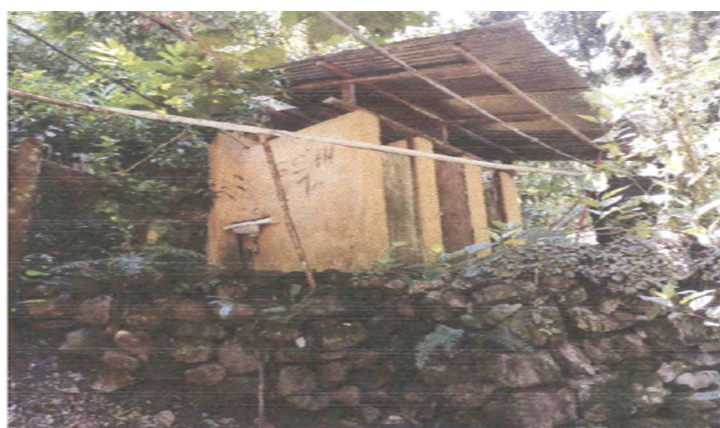
Vista del servicio higiénico construido por el señor Romel López Pérez, en la faja marginal (margen derecha) de la quebrada Las Pavas.
