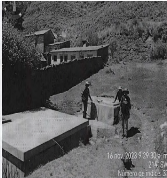
16 nov. 2023 9:29:30 a. m. 214° SW Número de índice: 37 Imagen 01.- podemos apreciar la fuente de agua superficial denominada manantial "OREJON", la cual se encuentra captada mediante una cámara de concreto para derivar sus aguas hacia un reservorio de concreto armado.
