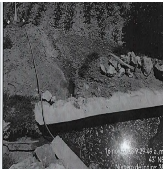
16 nov. 2023 9:29:49 a. m. 43° NE Número de índice: 38 Imagen 03.- podemos apreciar un estanque de agua para así derivar sus aguas hacia las áreas bajo riego de pastos naturales para el beneficio de los usuarios de la fuente de agua.
