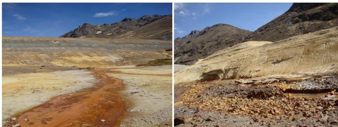
Fig. N°04: Pasivos ambientales ubicados en la parte alta de la cuenca del río Aruri (Qda. Parac). (a) Agua ácidas generadas por una cancha de desmontes. (b) Erosión del talud de la margen izquierda de la relavera.
