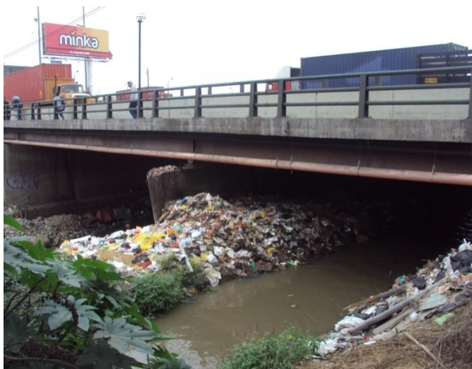
Botadero de residuos sólidos ubicado debajo del puente Faucett. - Callao
