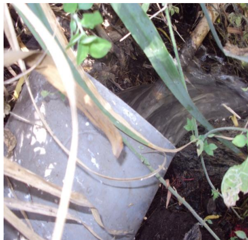
Vertimiento de aguas residuales domesticas sin tratamiento de I Dist. Santa Cruz de Cocachacra.
