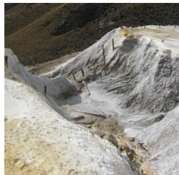
Relaveras erosionadas una ubicada en la naciente del río Santa Eulalia
