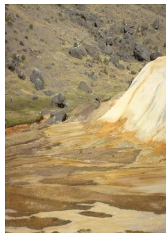
Relavera abandonada. Filtración de la parte inferior (izq.), talud deslizado (med.) y talud que limita con el cauce (der.) Río Aruri.
