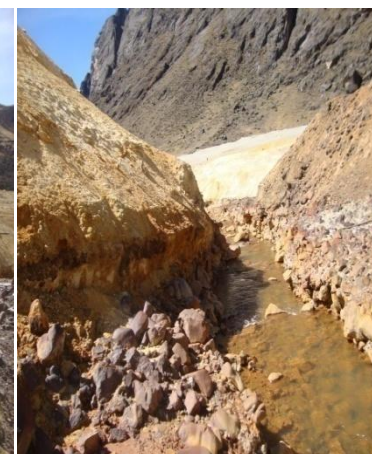
Relavera abandonada. Filtración de la parte inferior (izq.), talud deslizado (med.) y talud que limita con el cauce (der.) Río Aruri.
