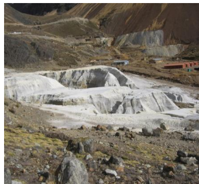
Relaveras erosionadas una ubicada en la naciente del río Santa Eulalia
