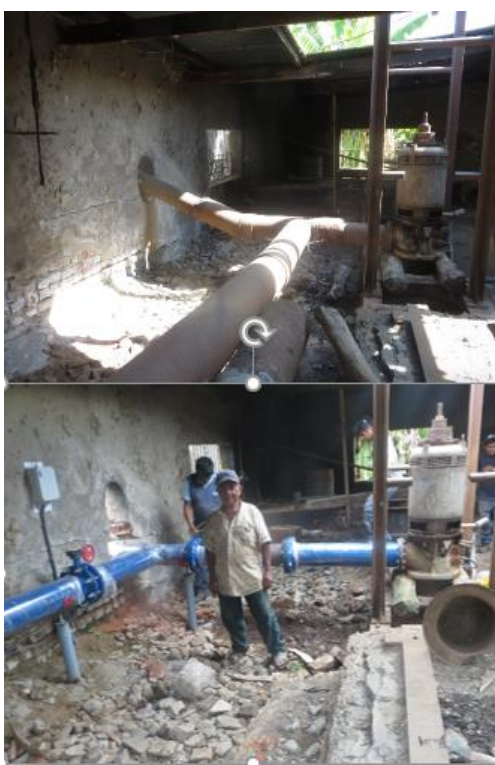
Pozo IRH 031 Tres Marías ALA Alto Piura
